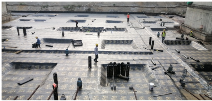
沧州项目施工现场
